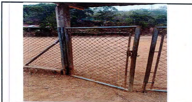
Foto 6: se observa el mantenimiento y rectificacion del porton de entrada del establecimiento.
