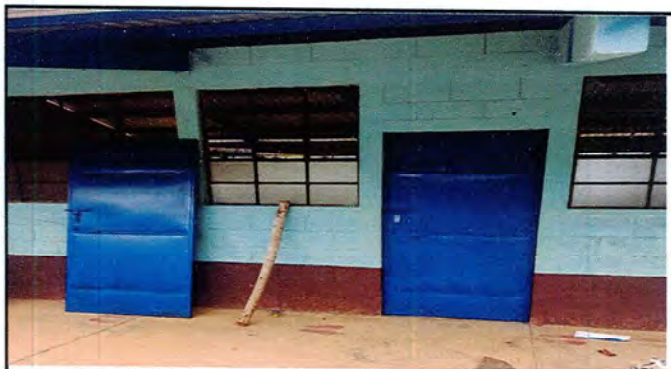
Foto 4: se observa el momento en que las puertas del establecimiento son extraidas de su lugar para su mantenimiento.
