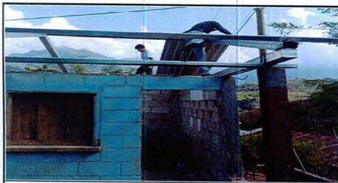
Foto 5: se observa la instalación de la estructura metalica y la instalacion de la lamina del techo de la cocina del establecimiento.
