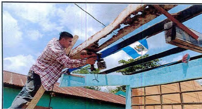
Foto 3: se observa el momento del mantenimiento de la estructura metalica del techo del establecimiento.
