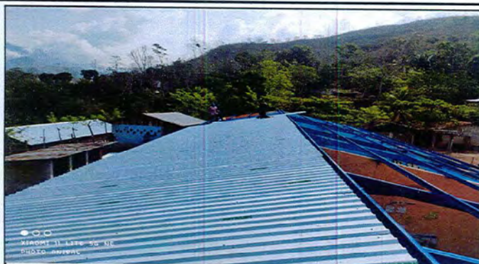
Foto 1: Se observa la instalación de las nuevas laminas al establecimiento.
